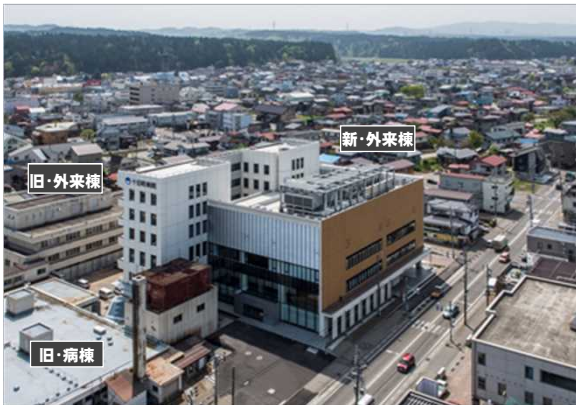
第1工区(新・外来棟部分)外観(H28. 3)
