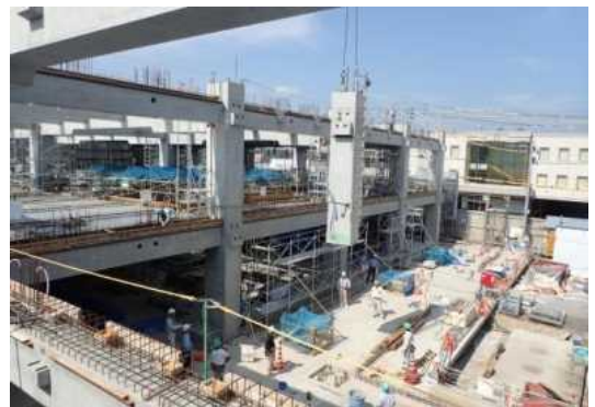
PCa・PC部材架設状況(第1工区)
