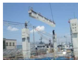
PCa梁建込み
